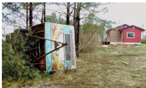
Esta casa construida por INTA se mantuvo en pie a pesar de que pasó un tornado por la zona. La foto muestra cómo el viento tumbó la casa rodante que ocupaba el personal de vigilancia.
