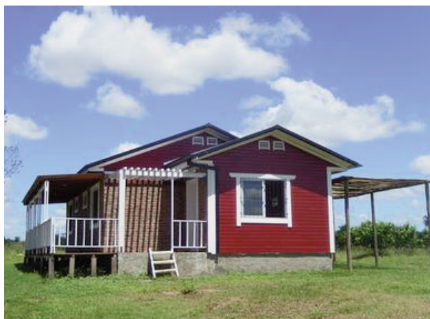
Vivienda de madera construida por INTA.
