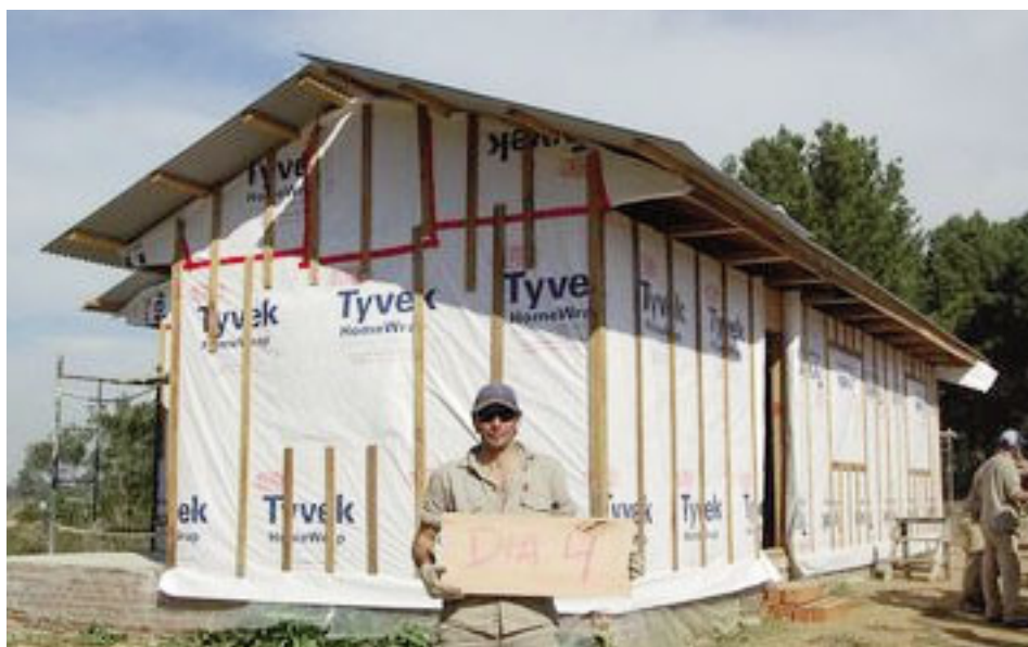
Colocación de las membranas gas permeable que, en un sentido dejan pasar vapor de agua, y en el otro sentido no dejan pasar agua. Tienen un sentido de colocación, por eso las empresas siempre dejan su marca comercial hacia el lado de afuera.
